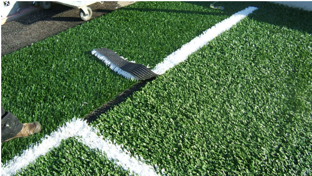
COLOCACION DE LAS LINEAS
