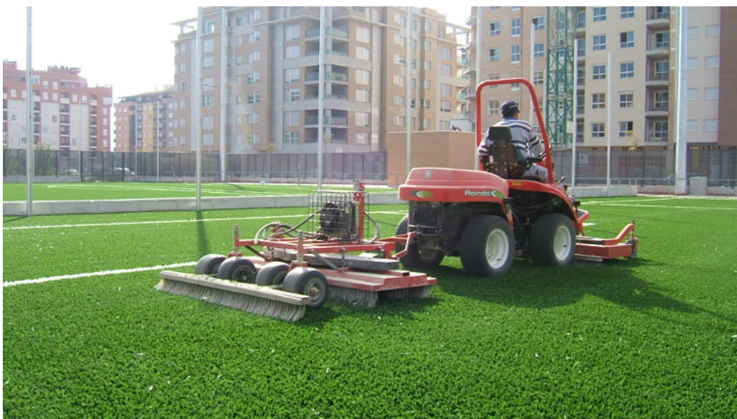
CEPILLADO DE LA SUPERFICIE
